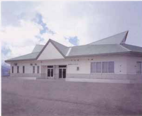
浸出水処理棟
